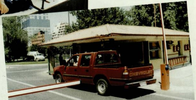
La instalación de barreras accionadas por control remoto en la Guardia N° 2 de calle Los Militares constituye un adelanto importante en materia de control de acceso y seguridad.
