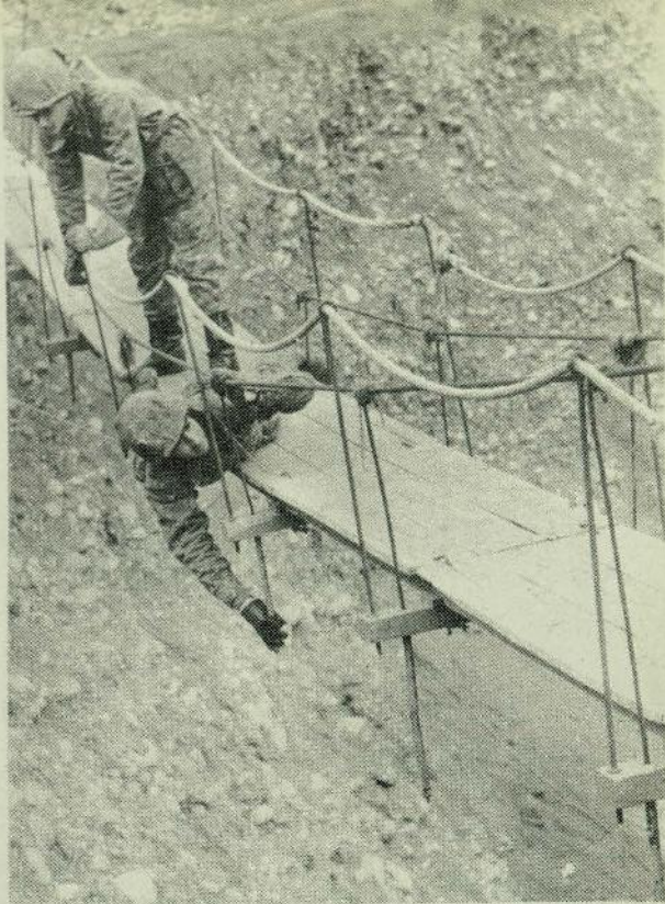
Construcción de pasarelas suspendidas en el área de instrucción de la Escuela, empleando material circunstancial
