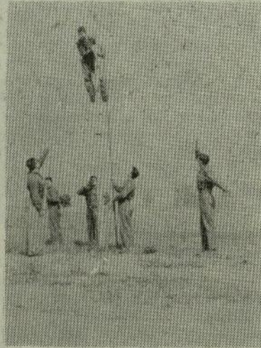
Alumnos del I Curso Militar efectuando una construcción de líneas telefónica, sobre postación permanente.
