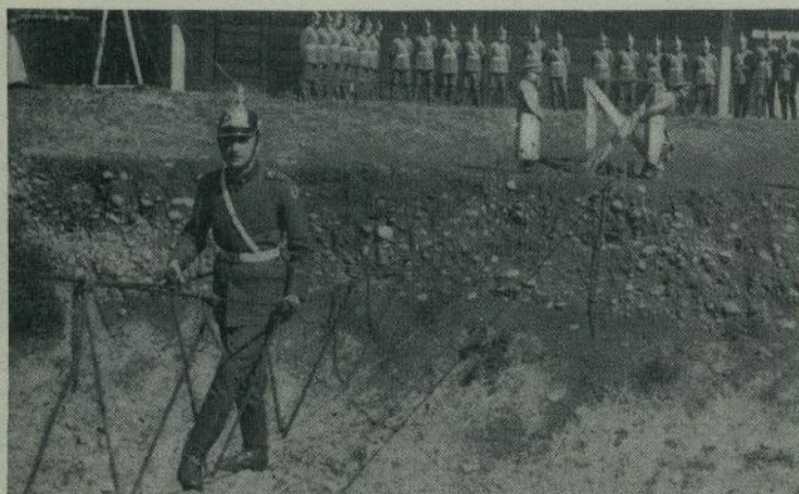
El Subalférez J. Hidalgo cruzando una pasarela de 3 cuerdas, durante la Revista en la parte de "Puentes".
